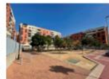
La planta piloto española del proyecto PRECEPT se realizará en 20 viviendas del barrio de Joven Futura en la ciudad de Murcia.
